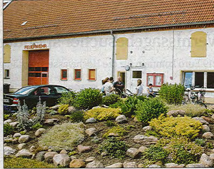
Saniert und neu eingedeckt ist der Gebäudetrakt, in dem Feuerwehr und Gemeinde untergebracht sind. Fotos (2): Stephen Zechendorf
