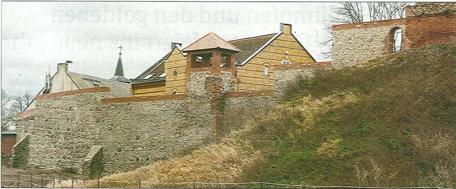
Mit der Rekonstruktion des Halbschalenturms und der Instandsetzung der Nordmauer konnte die Sanierung der Lindauer Vorburg 2011 abgeschlossen werden. Fotos (2): D. Apel
