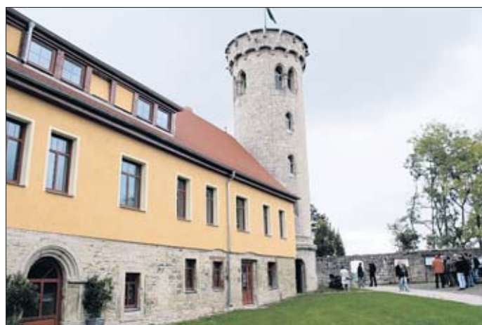
Zscheiplitz: Die Sanierung des Stall- und Gesindegebäudes auf dem Weingut Pawis und des Wasserturms wurde über Leder gefördert.
