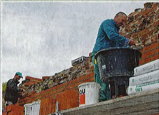
Schritt für Schritt erfolgt die Sanierung der Lindauer Burganlage.
