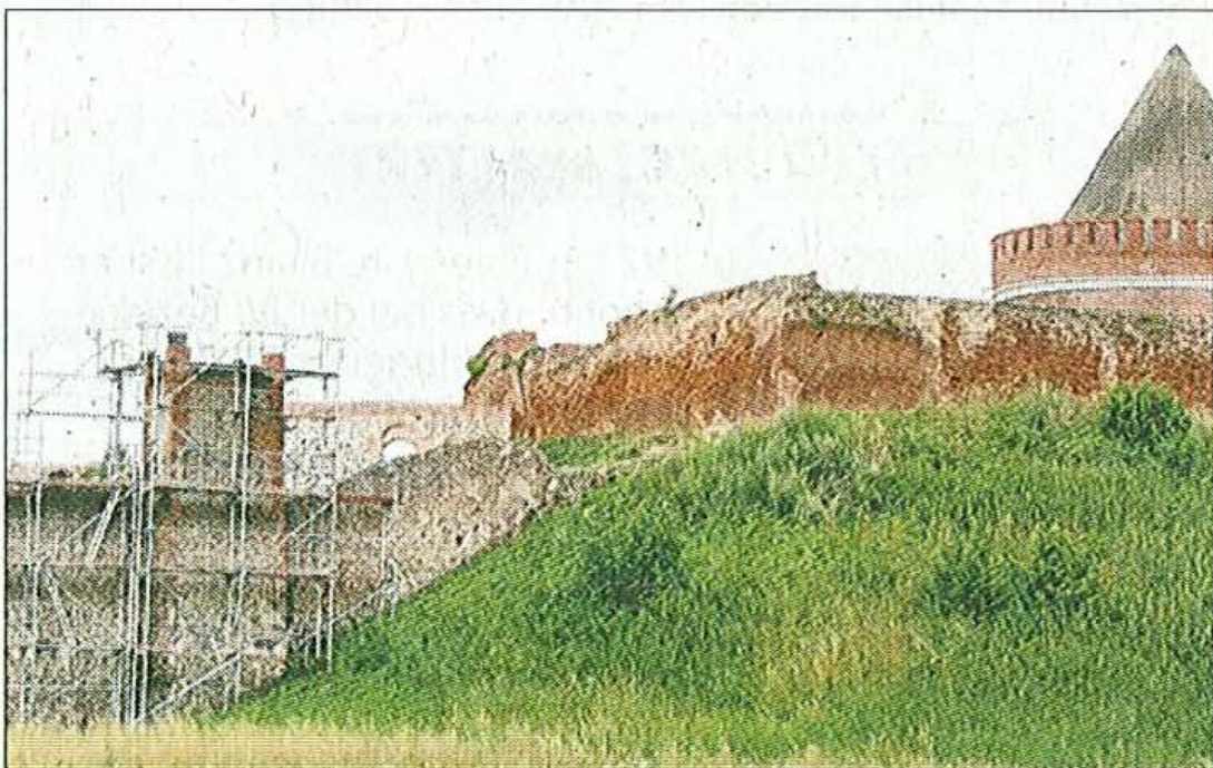
Auf der Lindauer Burganlage wird zur Zeit der Halbschalenturm in der Nordmauer der Vorburg saniert.
